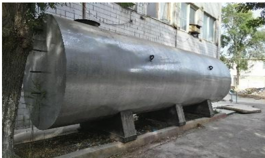
3-расм. Мавсумий иссиқлик сақлаш бак аккумулятори
