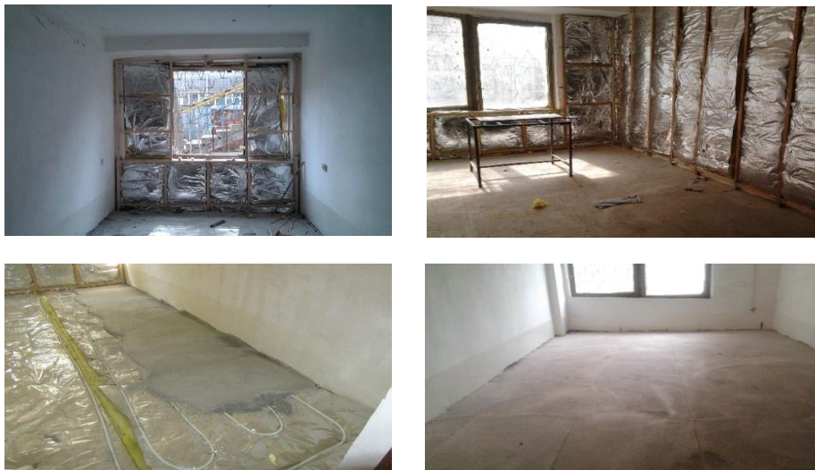
4-расм. Бинонинг ички томонидан иссиқ пол ва деворларнинг иссиқлик изоляция материаллари билан қопланиш жараёнлари
