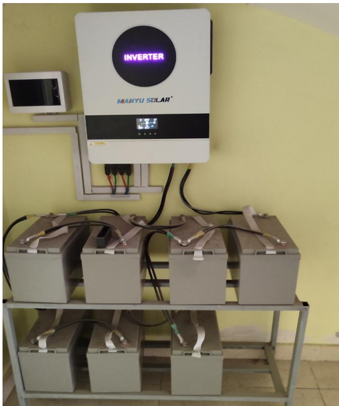
5-rasm. 49-sonli Maktabgacha ta'lim tashkiloti (MTT)ga o'rnatilgan FESning bir qismi.
