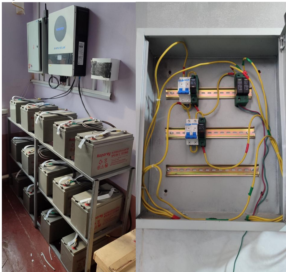
7-rasm. Mingbuloq tuman 14-umumiy o'rta ta'lim maktabida o'rnatilgan FESning Invertorlari va birlashtirish qutisi.
